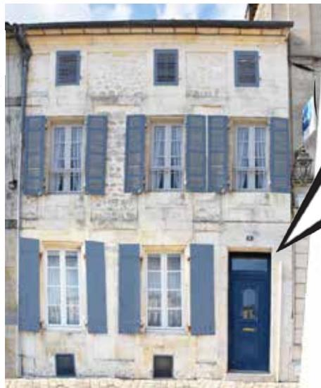
Voici la maison à l'origine. Elle se compose de plusieurs niveaux. Les menuiseries sont en bois. La façade est en pierre de taille pour la structure et en moellons recouverts d'enduit.
