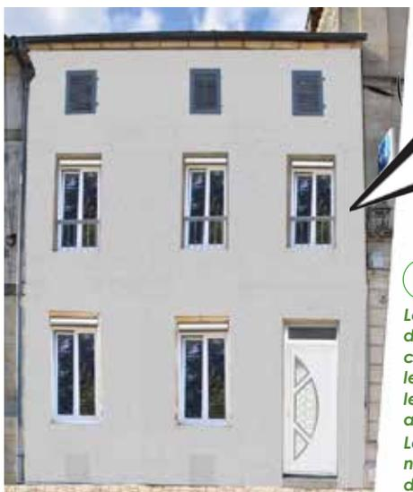
Pour mieux isoler leur logement et ne pas refaire un enduit à la chaux, ils ont fait poser une isolation thermique par l'extérieur
