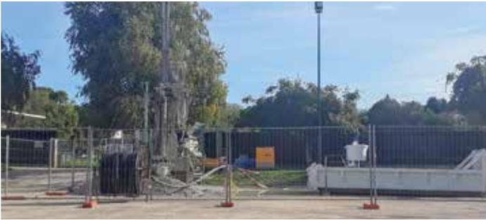
Les travaux de la pose des sondes géothermiques ont débuté, celles-ci vont véhiculer l'énergie, qui va permettre de chauffer le bâtiment du 10 Place de la Mairie.
